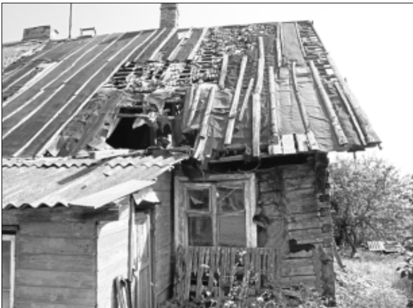
Pussabrukušā dzīvokļa jumts. Mājas iedzīvotāji stāsta, ka nama astotā dzīvokļa jumts brūk kopā arvien vairāk un vairāk, tādēļ nepieciešama palīdzība. Balvu pagasta pārvaldnieks Andris Ķerāns ļoti cer palīdzēt iedzīvotājiem, nepieciešamos darbus varēs uzsākt jau tuvākajā laikā.
