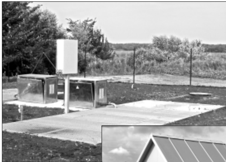
Attīrīšanas ietaises. Lielākais būvniecības darbs atrodas zem zemes.
