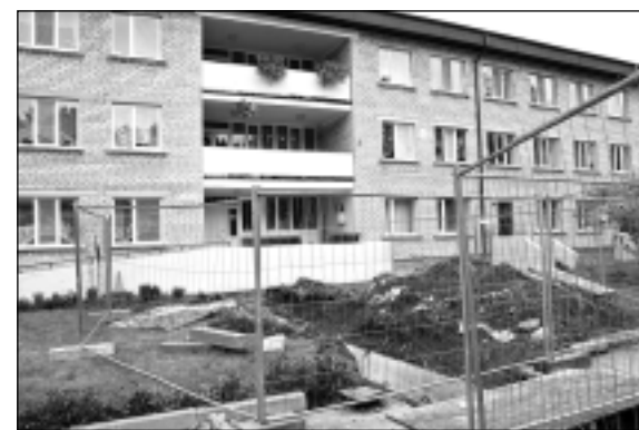
Renovē apkures sistēmu. Tā izskatās pensionāta "Balvi" priekšpusē.
