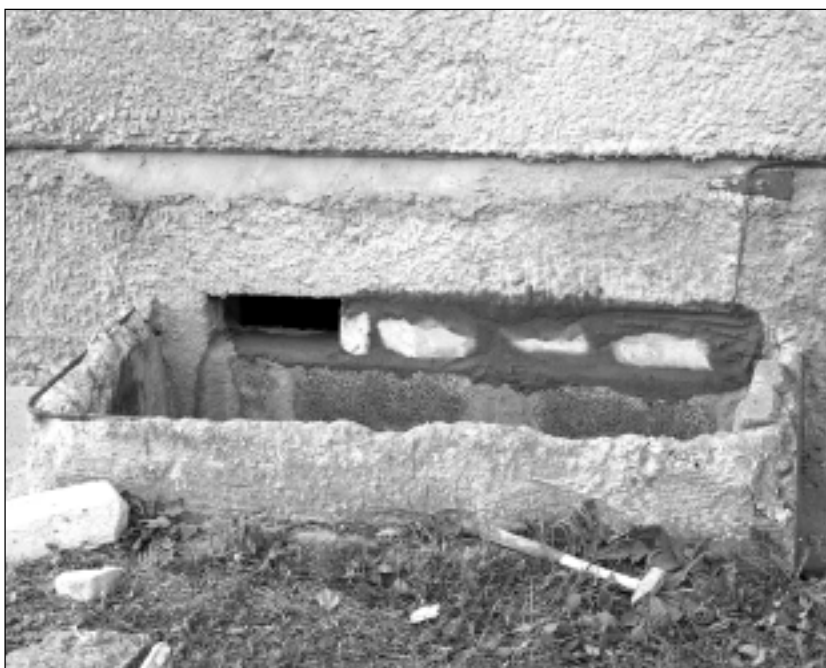
Aizmūrētie logi. Mūrējuma vietās atstāta neliela, brīva vieta ventilācijai.
