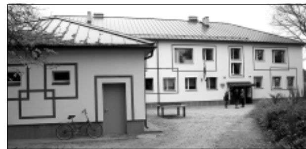
No ārpuses. Iepriekš necilā Balvu Bērnu un jauniešu centra ēka pārvērtusies līdz nepazīšanai.
