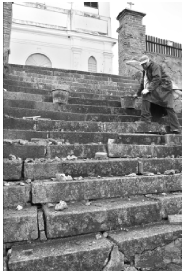
Atjauno kāpnis. Par baznīcas kāpņu, žoga un vārtu atjaunošanas darbiem gādā SIA “Veskor”.
